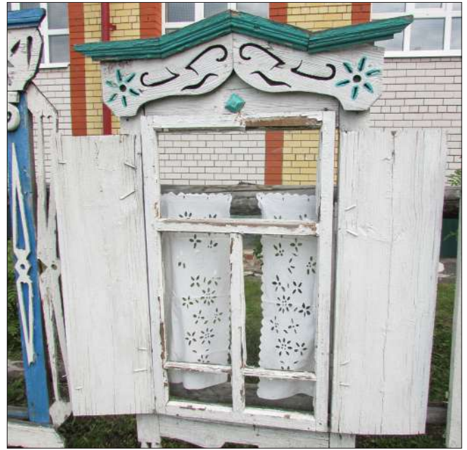
Наличник оконный с рамой и ставнями. 2-я пол. XX в. Дерево, краска. Пропильная щелевидная резьба. Школьный музей под открытым небом. д. Татарские Сугуты Батыревского района.
